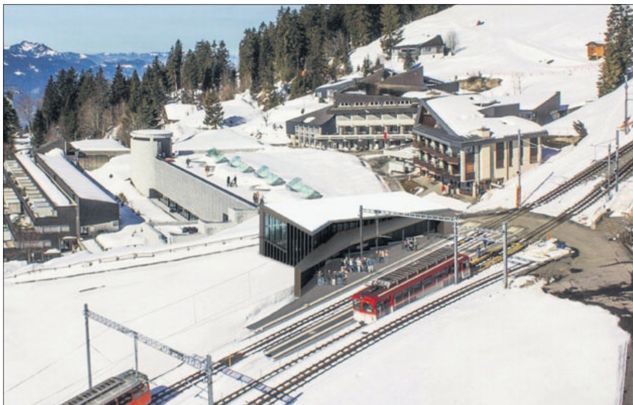
So soll das rund 3 Millionen Franken teure Stationsgebäude auf Rigi Kaltbad aussehen.
